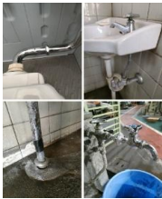
各漏水箇所修理
