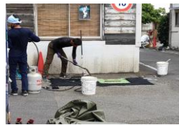
漏水箇所修理工事
